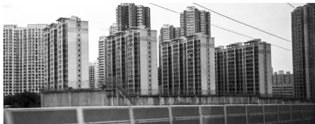
Tomada desde el tren de alta velocidad mientras pasaba junto a nuestro edificio (el segundo edificio más corto desde la derecha).
